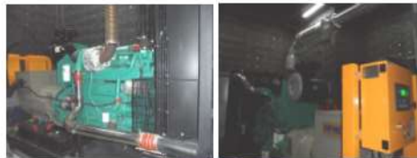
ภาพที่ 3-5 ห้องเครื่องกักไฟฟ้าสำรอง
